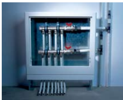
Подводка трубы к коллекторам
