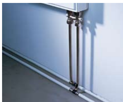
Подсоединение с помощью подводки для радиаторов
