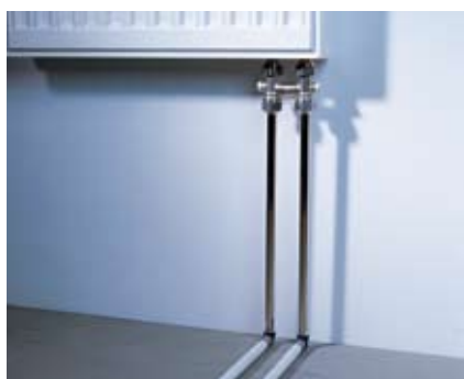
Подсоединение с помощью подводки для радиаторов
