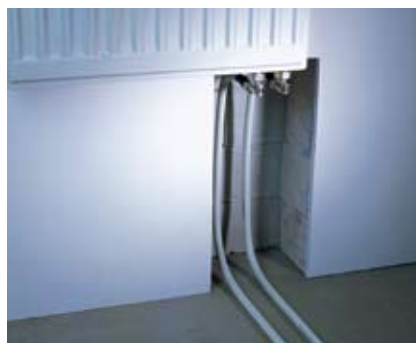
Непосредственное подключение трубы к радиатору
